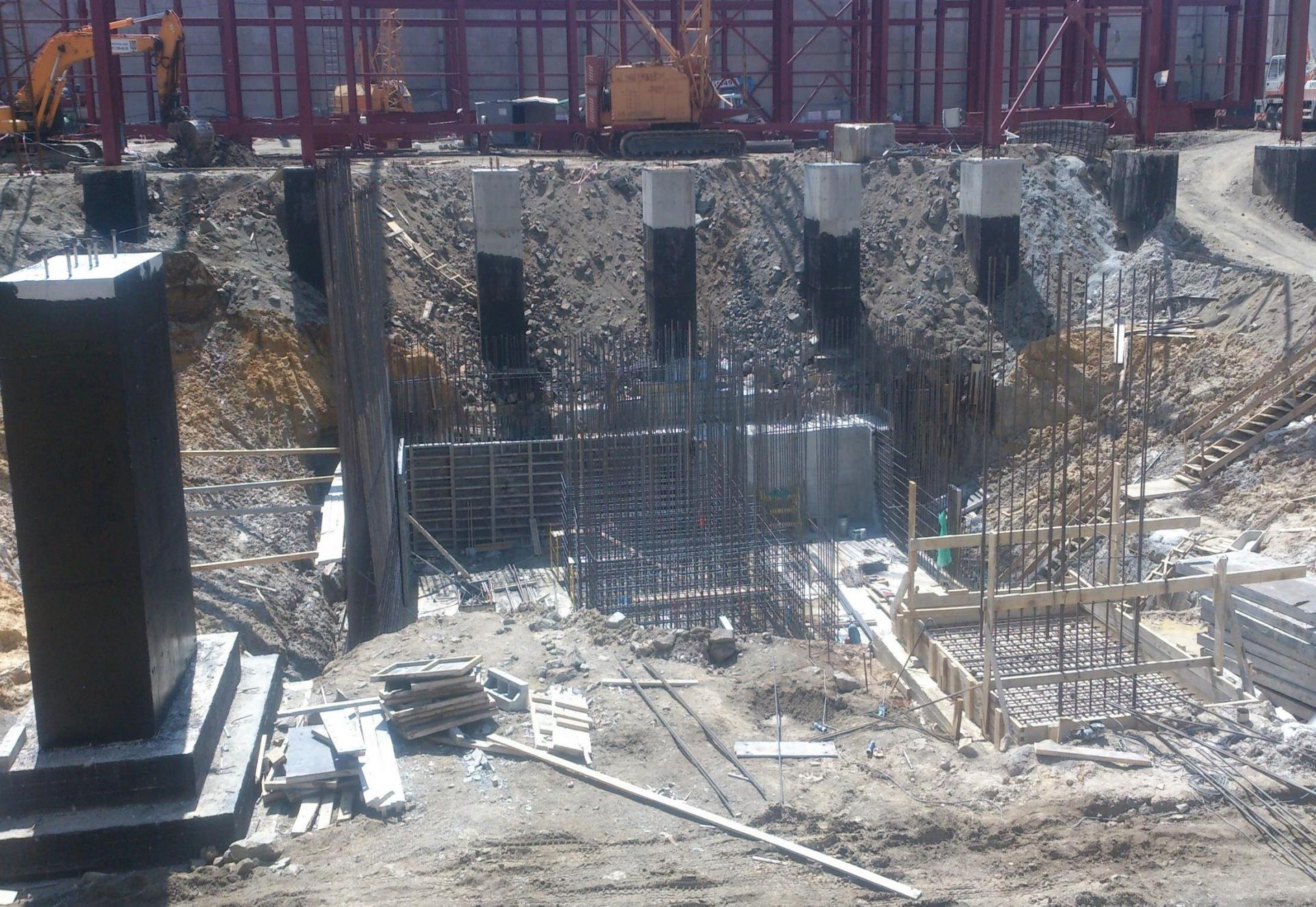
Возведение фундаментов опорных колонн и стен бассейна
