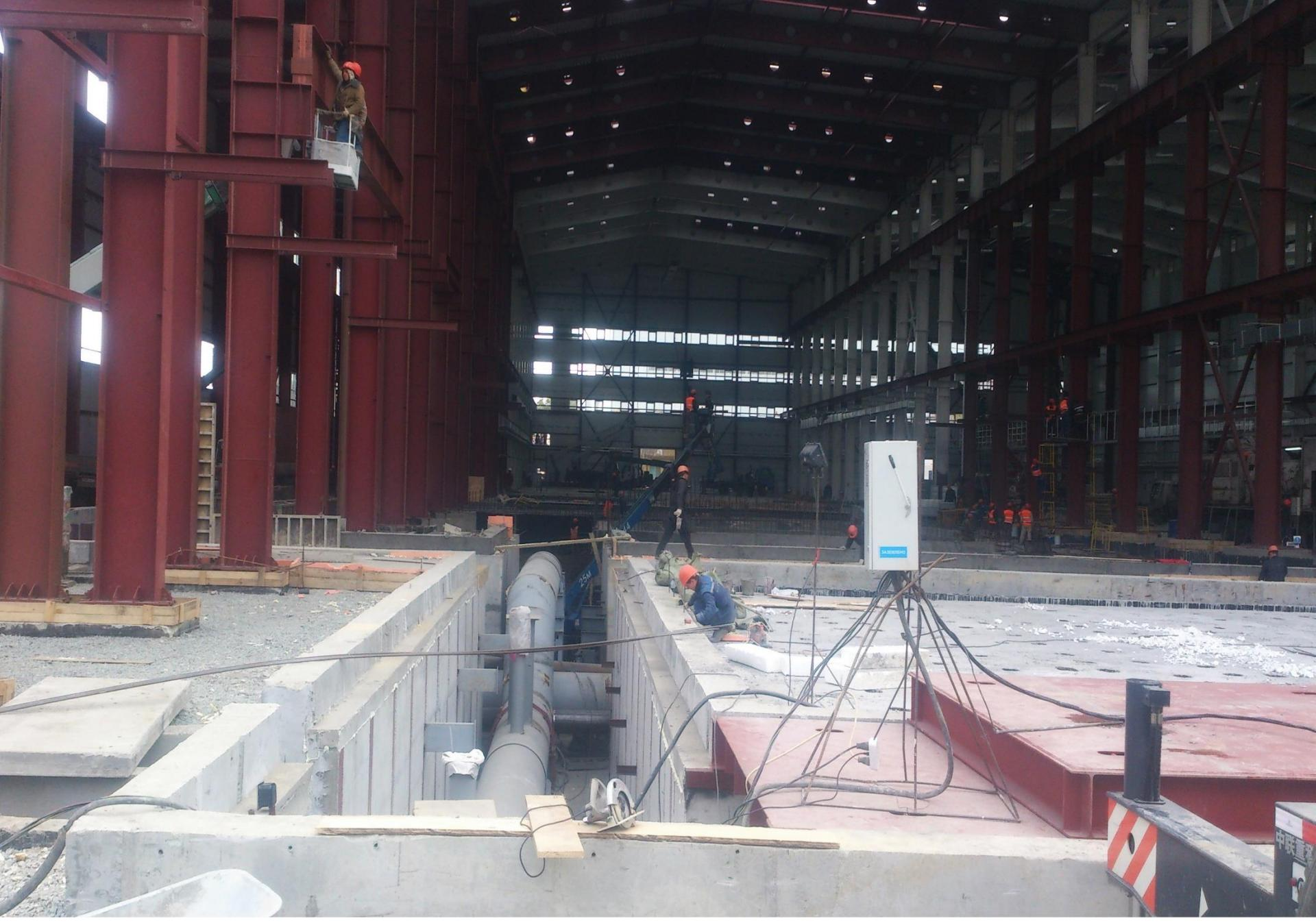
Монтаж трубопроводов для испытания горизонтальных насосов
