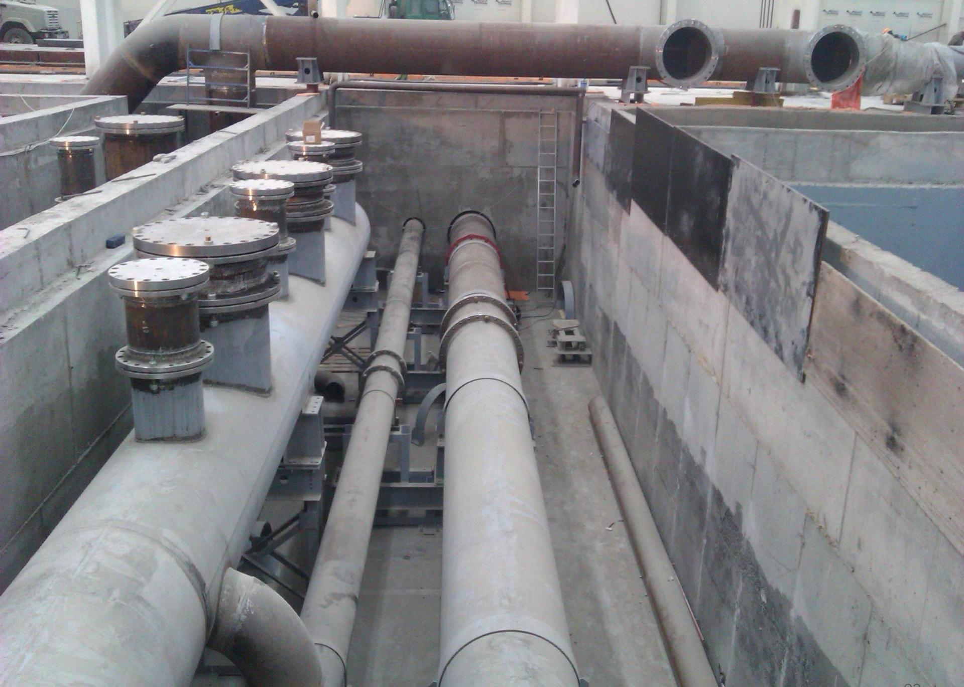
Монтаж трубопроводов для испытания вертикальных насосов
