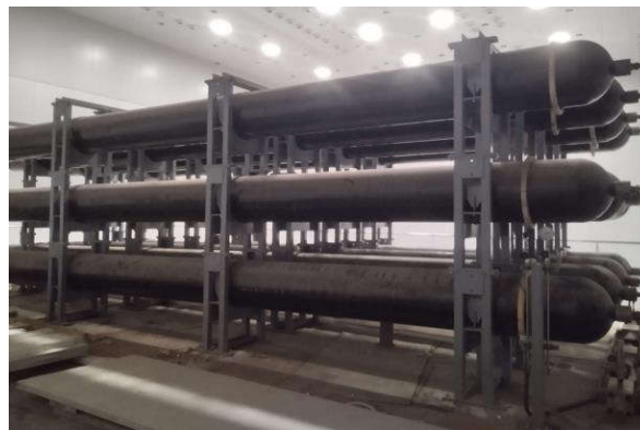
Рис. 3. Внешний вид комплекта баллонов высокого давления СВС
