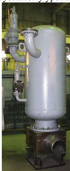
Рисунок 1. Компенсатор гидроударов на участке отгрузки готовой продукции ООО «УРИЦ»
