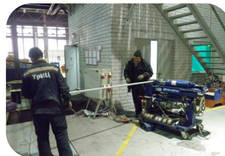
Трубная разводка и монтаж
