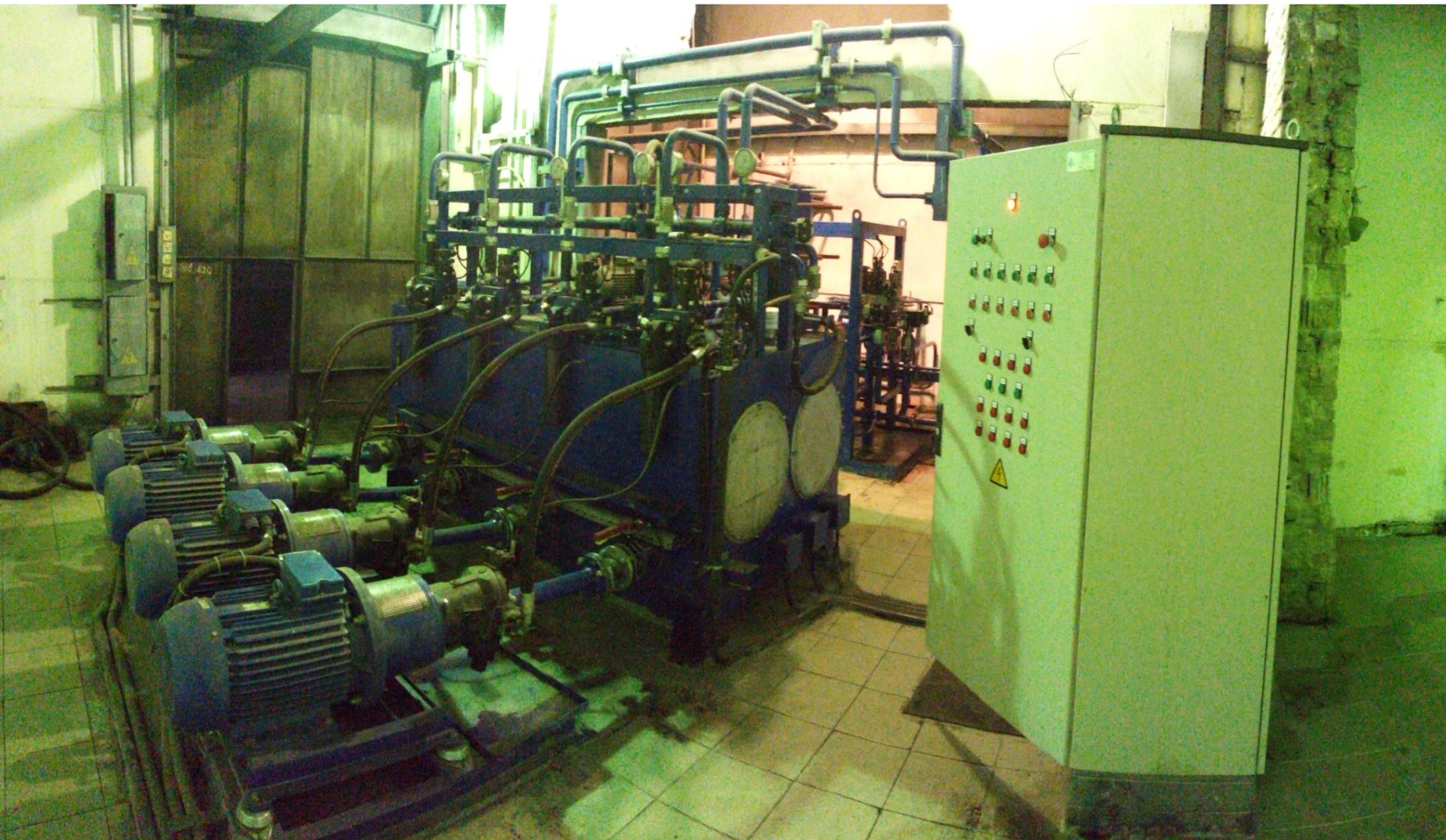
Основная гидростанция управления ДСП-25 (Ижевск)
