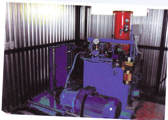
Рис. 2. Общий вид насосной установки стенда для испытаний баллонов на циклическую долговечность производства ООО "Учебно-инжиниринговый центр" (г. Челябинск)
